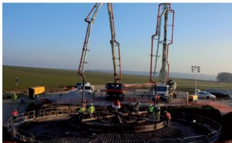
Une dizaine d'heures est nécessaire pour couler les 630 m<sup>3</sup> de béton. Celui-ci doit être vibré en permanence, afin d'éviter la formation de petites bulles d'air.
