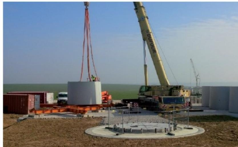
Le montage des éléments doit se faire par temps calme. Le mât, subdivisé en plusieurs sections, est assemblé sur la virole, prise dans le béton des fondations.
