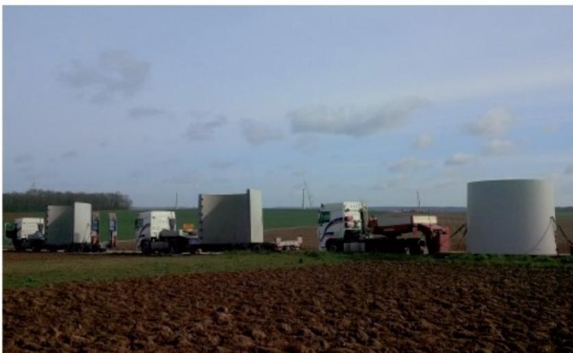
Les sections de mâts, les pales et la nacelle arrivent en pièces détachées et sont assemblées sur la plateforme.
