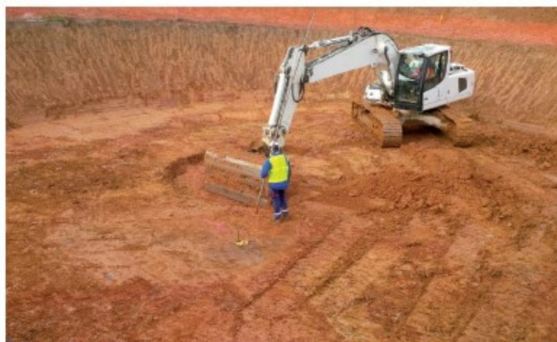
Des fouilles de 17,8 m de diamètre et de 3,25 m de profondeur sont creusées pour y accueillir les fondations des éoliennes, ce qui représente un volume d'excavation d'environ 1500 m<sup>3</sup>.
