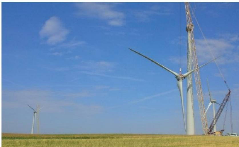
La nacelle est levée et fixée au mât. Vient ensuite l'assemblage au sol du rotor constitué des trois pales fixées sur le hub, et enfin son levage par une grande grue.
