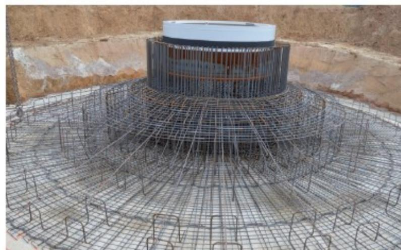
Vient alors la phase de ferrailage, qui permet de répartir les contraintes exercées par le poids de l'éolienne.
